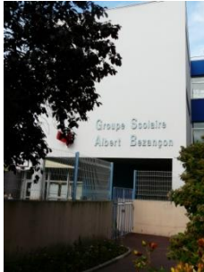
Le bâtiment principal
